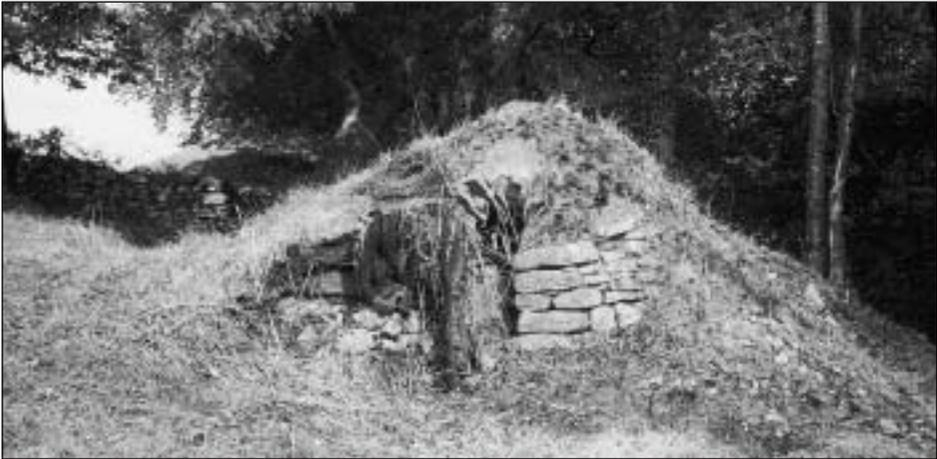
Foto 5. Alzado frontal de la nevera, muy deteriorado por el abandono y la vegetación
