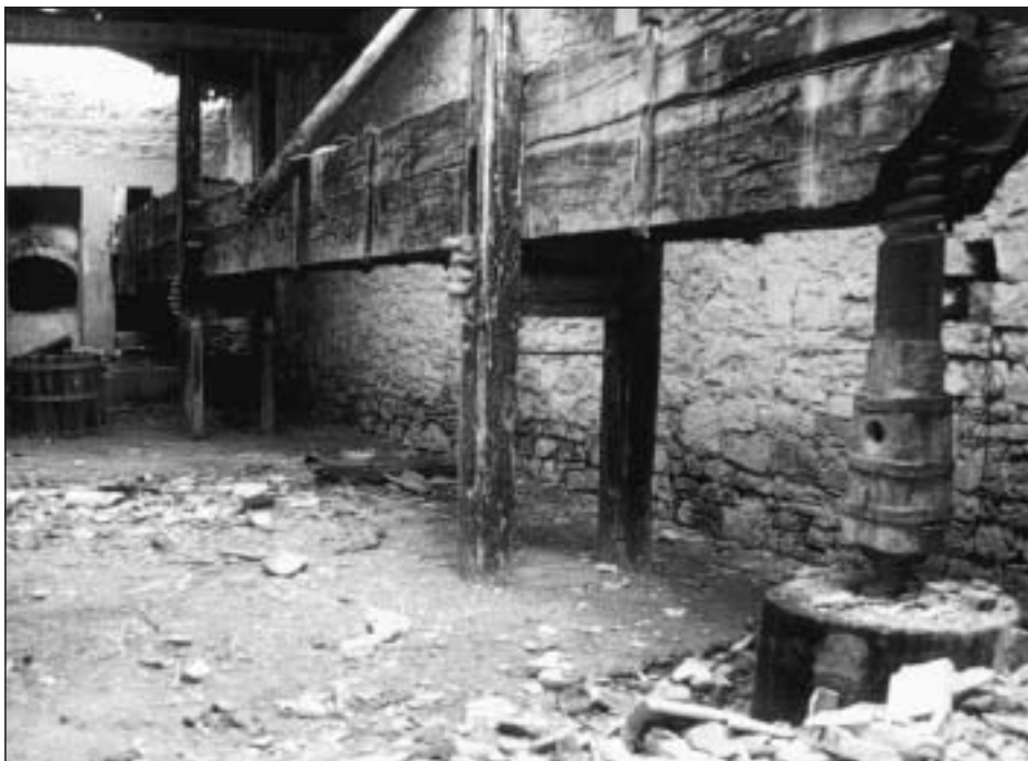
Interior del trujal de la Marquesa, en Cabanillas, antes de la restauración de la cubierta. Se aprecia la prensa de viga y quintal de 16 m de longitud
