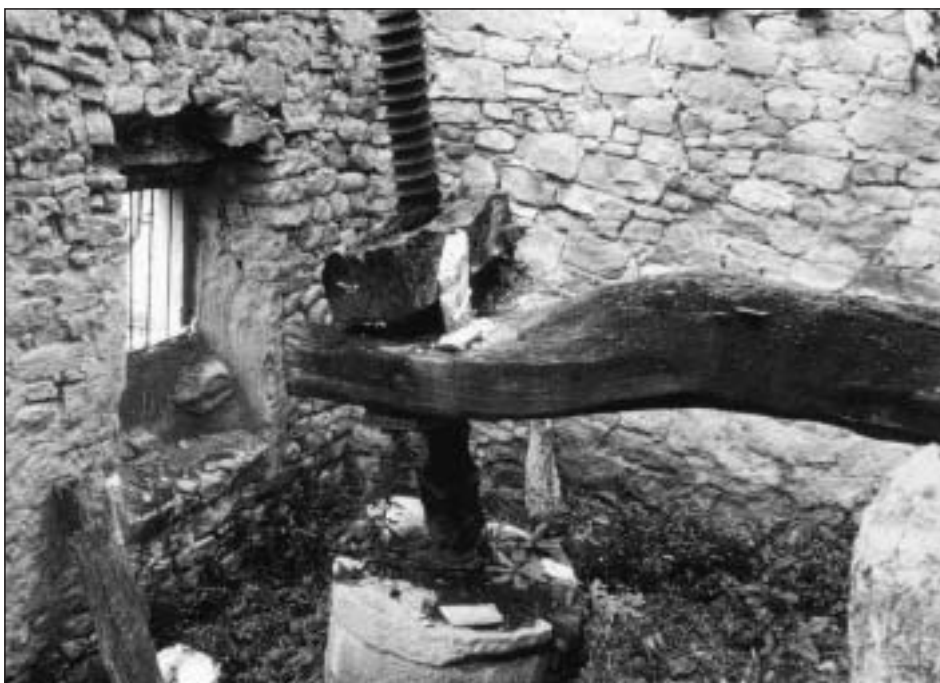
Interior del trujal de casa Gómez de Segura, en Dicastillo, con su prensa de viga de 8 m de longitud. El edificio está en situación de ruina irreversible
