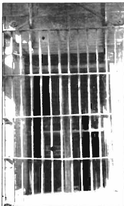
Lám. 8. Verja de la antigua entrada de la parroquial de Santiago, procedente de Leyre; 2. Verja, Calle Mayor, 14, Palacio de los Guenduláin.
