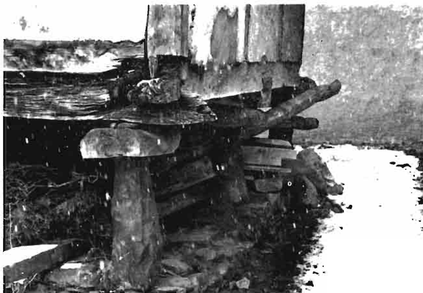
Foto 4.—Detalle de los pilares y entramado de la sustentación
