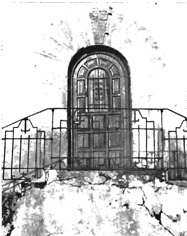
15.—Apesui. Portal con escaleras laterales.
