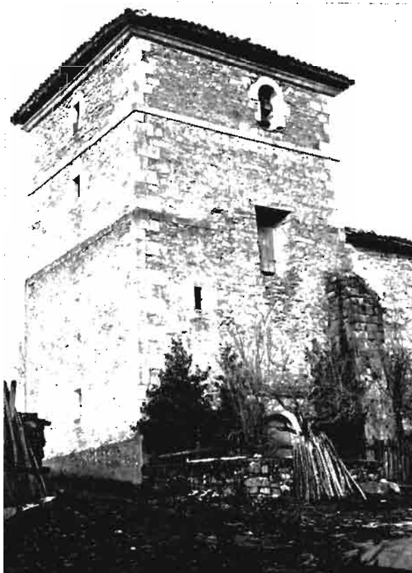
8.—Torre de la iglesia de Ureta.
