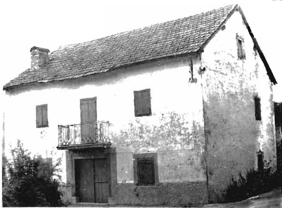
3.— Txorrondo . Casa Juan Miguelena, construida en 1905. Actualmente reformada. Ha conservado el tejado a dos aguas, con caída de mucha pendiente que evita el excesivo acumulamiento de la nieve.
