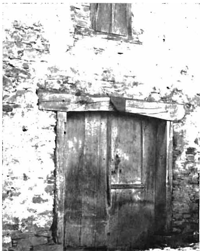
16.—Marcos y cabezal de madera sobre soportes de piedra.
