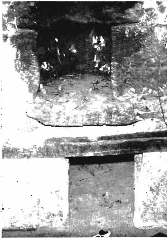
Foto núm. 16.—Boca de un horno de cocer el pan. Debajo, la boca del cenicero.
